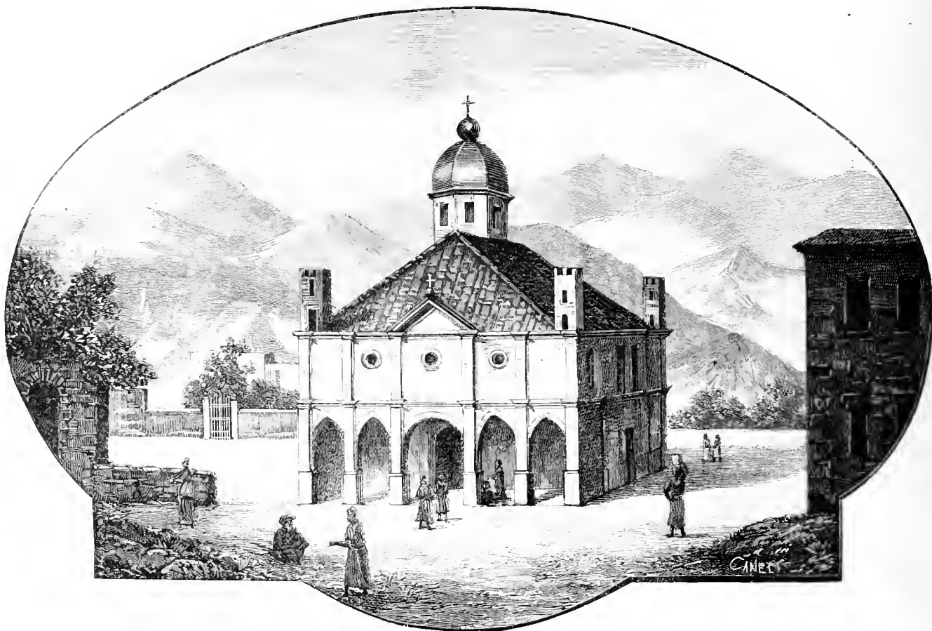
SYRIE. — ÉGLISE DE GEDAIDAH : d'après un dessin envoyé par MGR GÉRAIGHY (Voir page 621)
