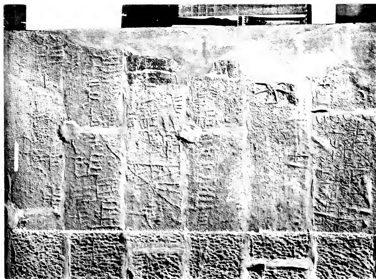
A) Pylone. Montant extérieur - sud de la porte
