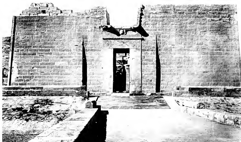
B) — Escalier et façade du pylone
