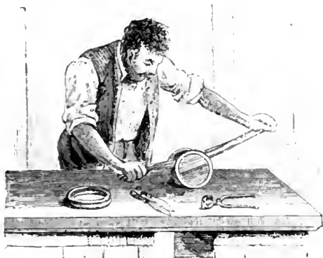
Fig. 280. — Raddrizzamento degli aghi.
