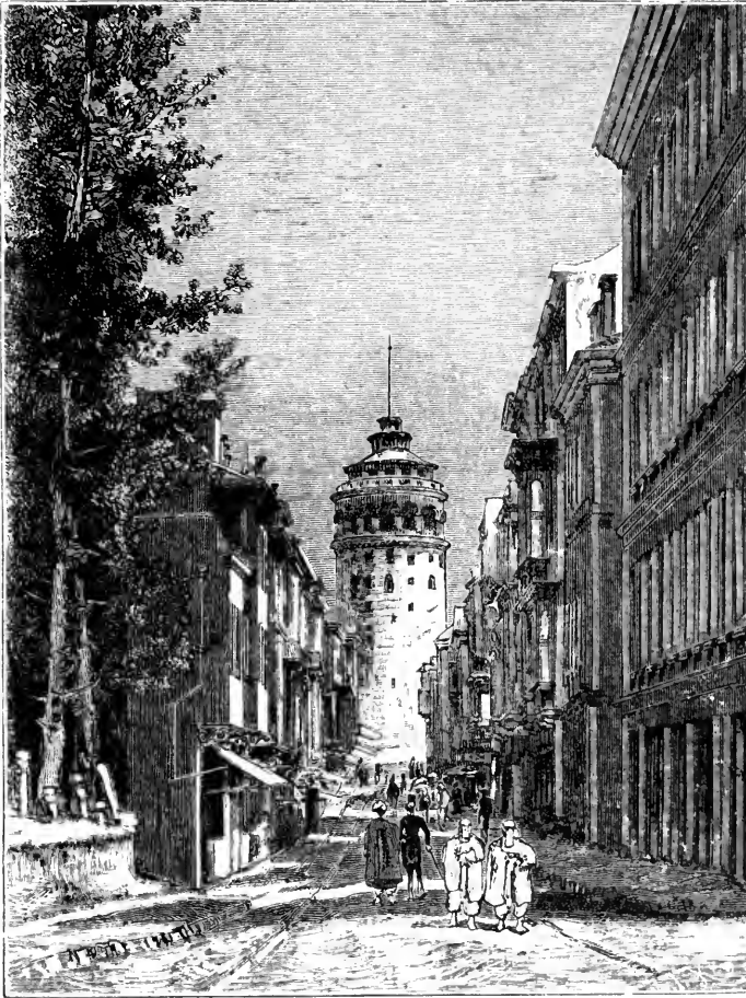
Fig. 2572. — Costantinopoli. Torre di Galata.
