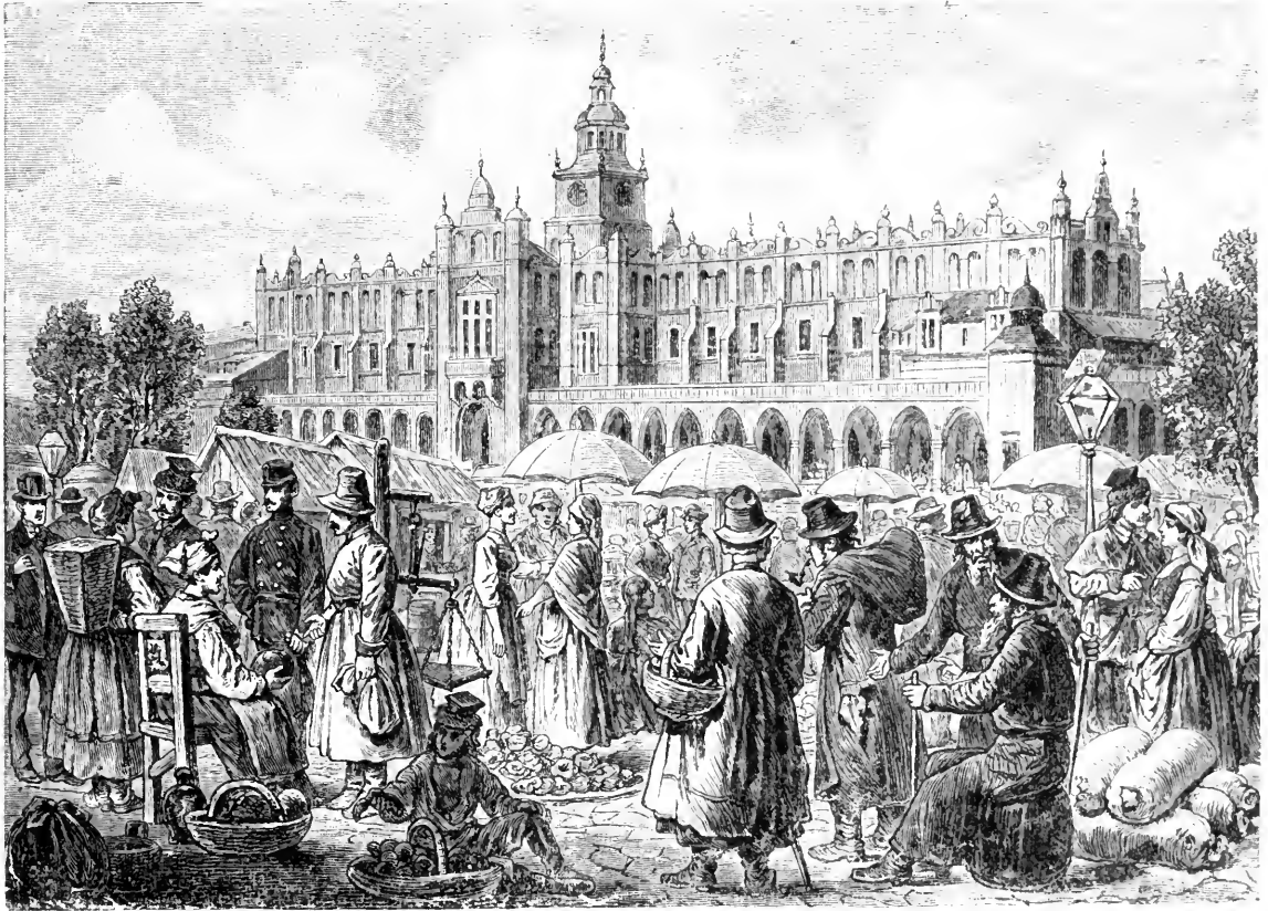
Fig. 2568. — Mercato in Cracovia.
