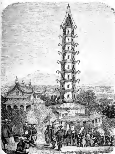
Fig. 2176. — Cina. Torre di porcellana a Nanching.
