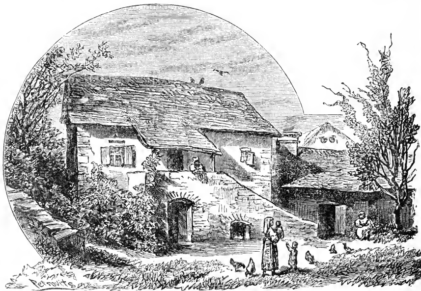
Fig. 2866. — Casa d'abitazione in Darnisch.
