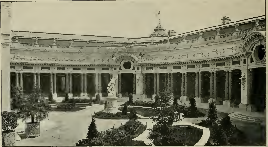
GALERIE CIRCULAIRE DE LA COUR INTÉRIEURE DU PETIT PALAIS
