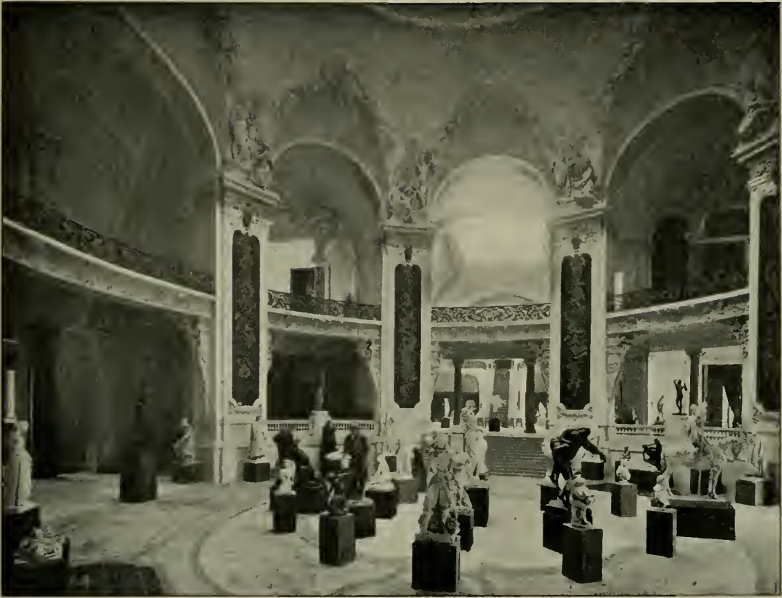
LA SCULPTURE DE LA CENTENNALE DANS LA ROTONDE OUVRANT SUR L'AVENUE D'ANTIN
