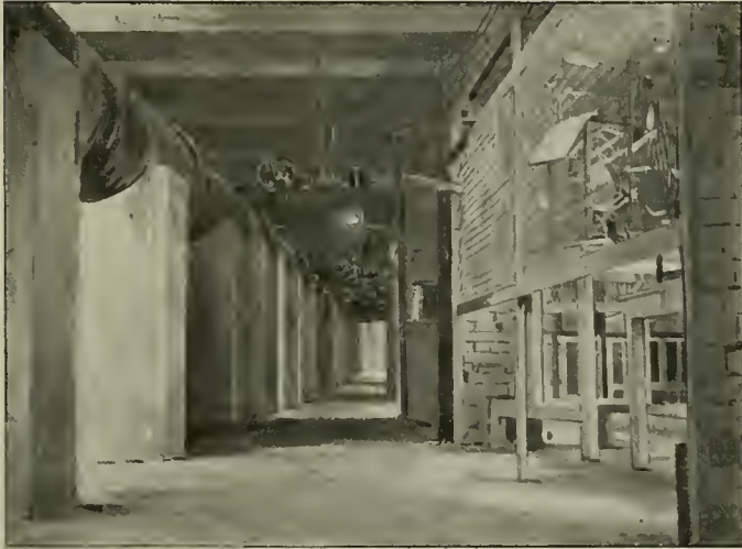
UNE DES GALERIES SOUTERRAINES SOUS LE BASSIN DU CHATEAU D'EAU
