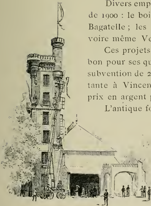
TOUR DE SIX ÉTAGES ÉLEVÉE POUR EXPÉRIMENTER LA MANŒUVRE DES ÉCHELLES DE SAUVETAGE SHERRER
