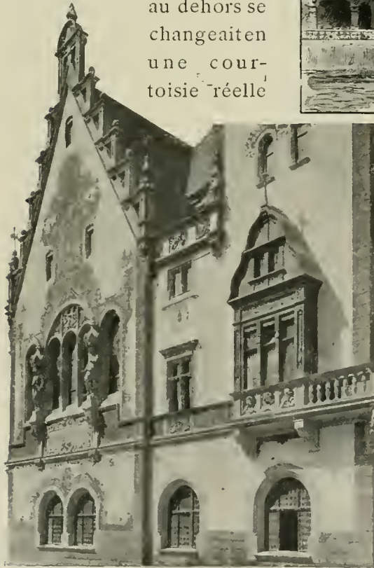
FAÇADE LATÉRALE DU PAVILLON IMPÉRIAL
