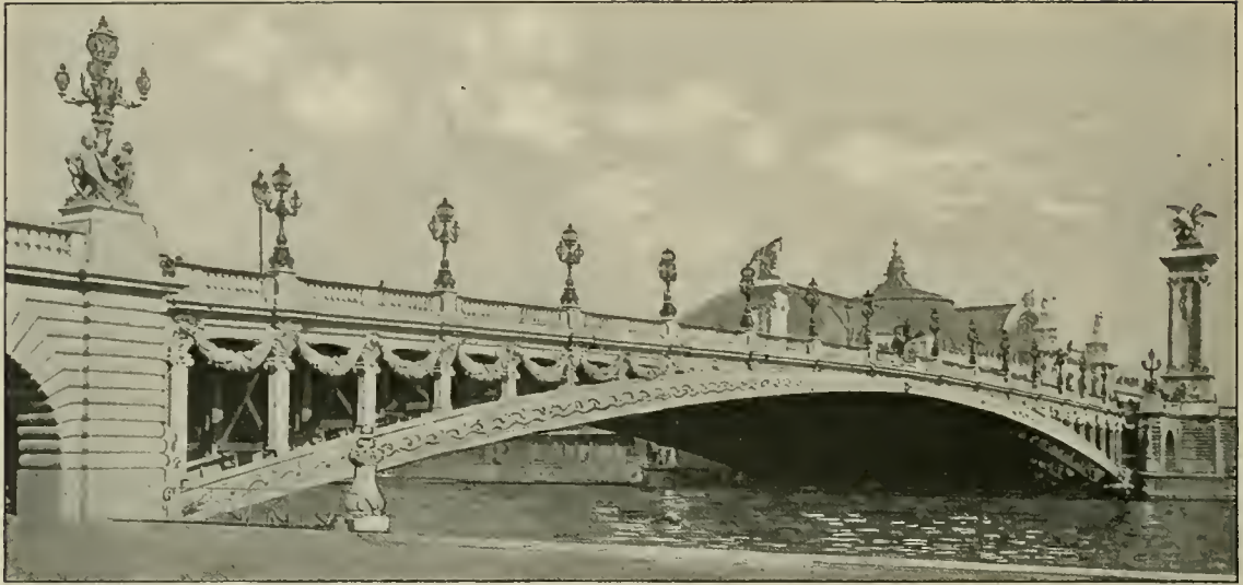
TABLIER DU PONT ALEXANDRE III — VUE PRISE D'AMONT
