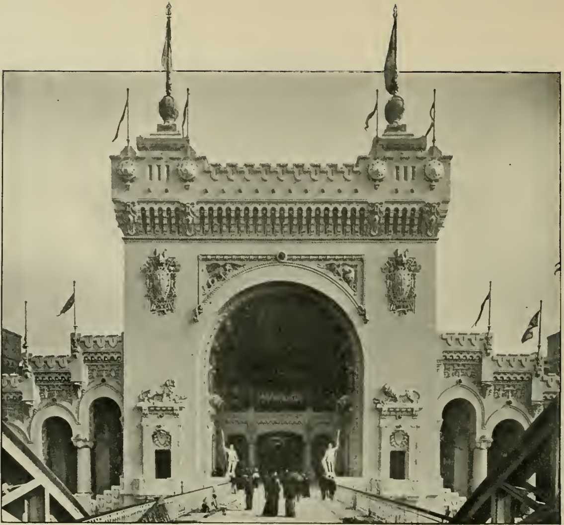
PORCHE CENTRAL DU PALAIS DES ARMÉES DE TERRE ET DE MER OUVRANT SUR LA PASSERELLE DE LA SEINE
