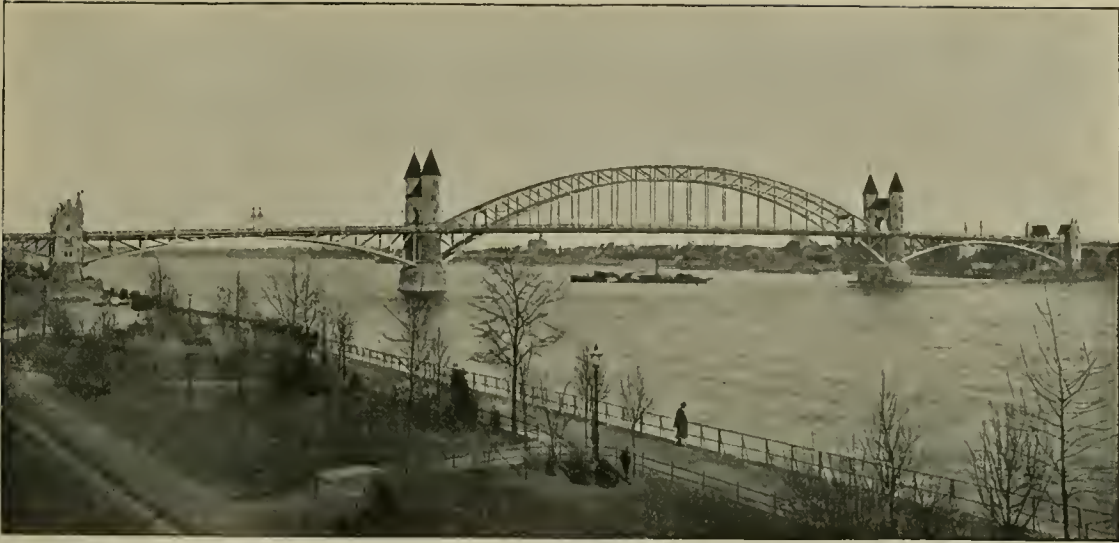
LE PONT DU RHIN, A BONN — Tableau exposé par la Société de construction d'Oberhausen.
