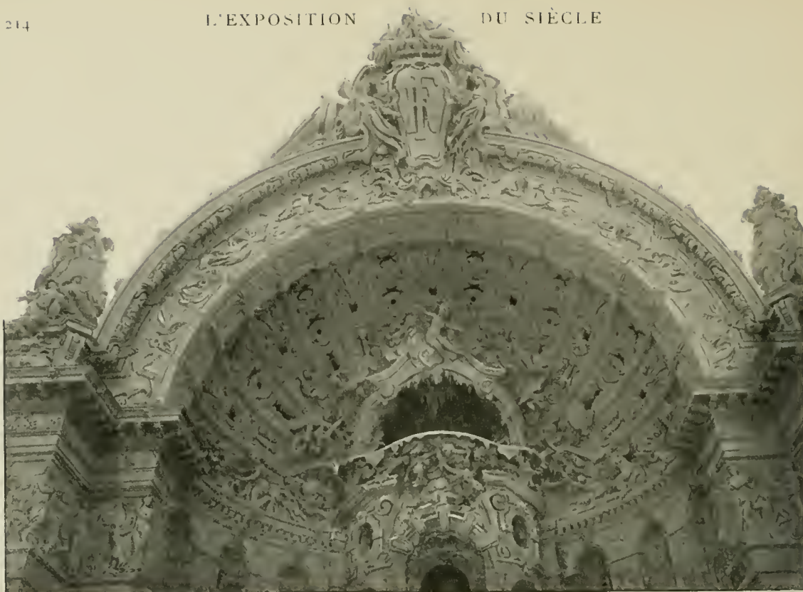
VOUTE DU CHATEAU D'EAU — AU CENTRE LA VASQUE D'ARRIVÉE DES EAUX
