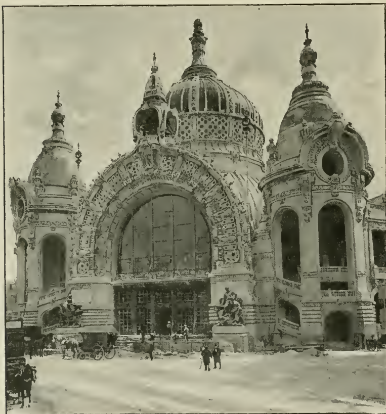
GRAND PORCHE D'ANGLE DU PALAIS DES MINES ET DE LA MÉTALLURGIE
