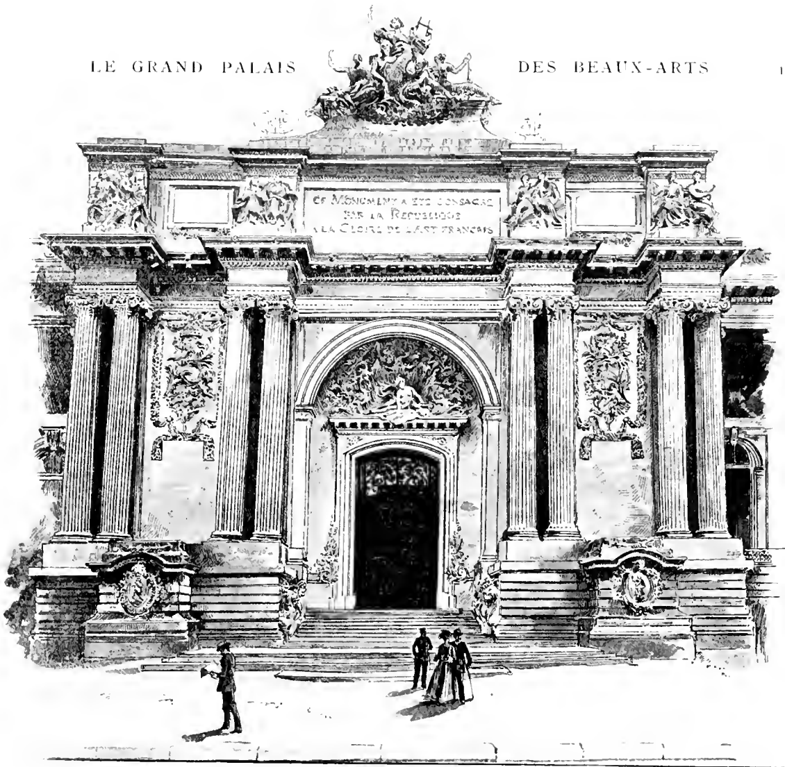
PORCHE PRINCIPAL DE LA FAÇADE SUR L'AVENUE D'ANTIN
