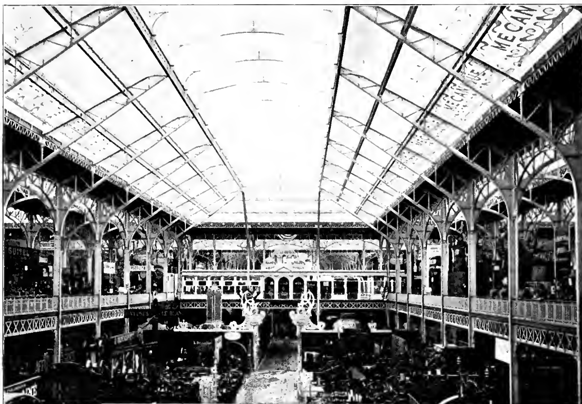
VUE D'UNE DES TROIS TRAVÉES DU PALAIS DE LA MÉCANIQUE
