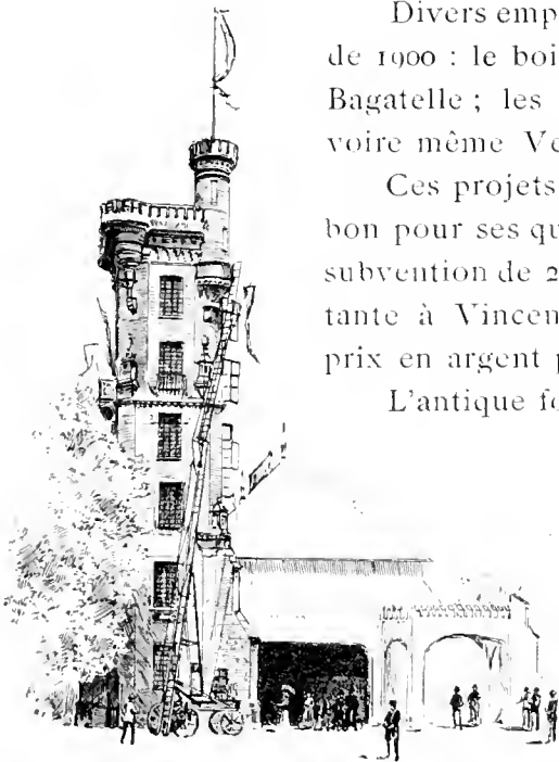
TOUR DE SIX ETAGES ÉLEVÉE POUR EXPÉRIMENTER LA MANŒUVRE DES ÉCHELLES DE SAUVETAGE SHERRER
