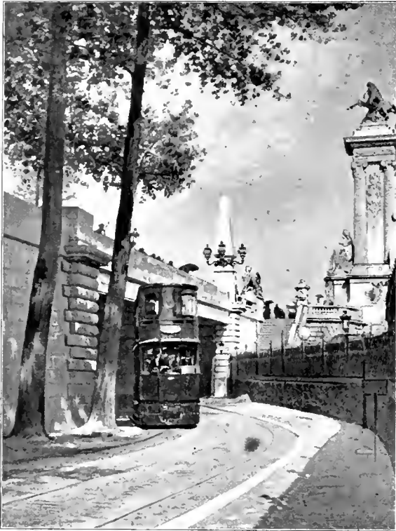
PASSAGE DU TRAMWAY SOUS L'AVENUE NICOLAS II à l'entrée du pont Alexandre III
