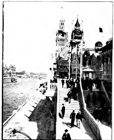
ESCALIERS PRÈS LE PONT DE L'ALMA
