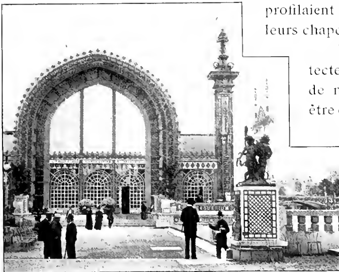
PORCHE D'ENTRÉE D'UNE SERRE
