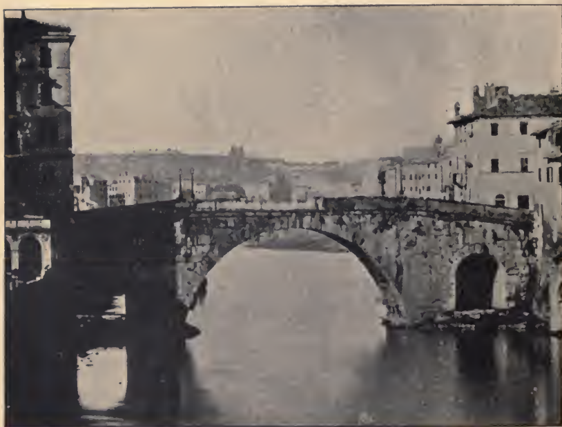
FIG. 16. — LE PONT DE GRATIEN
