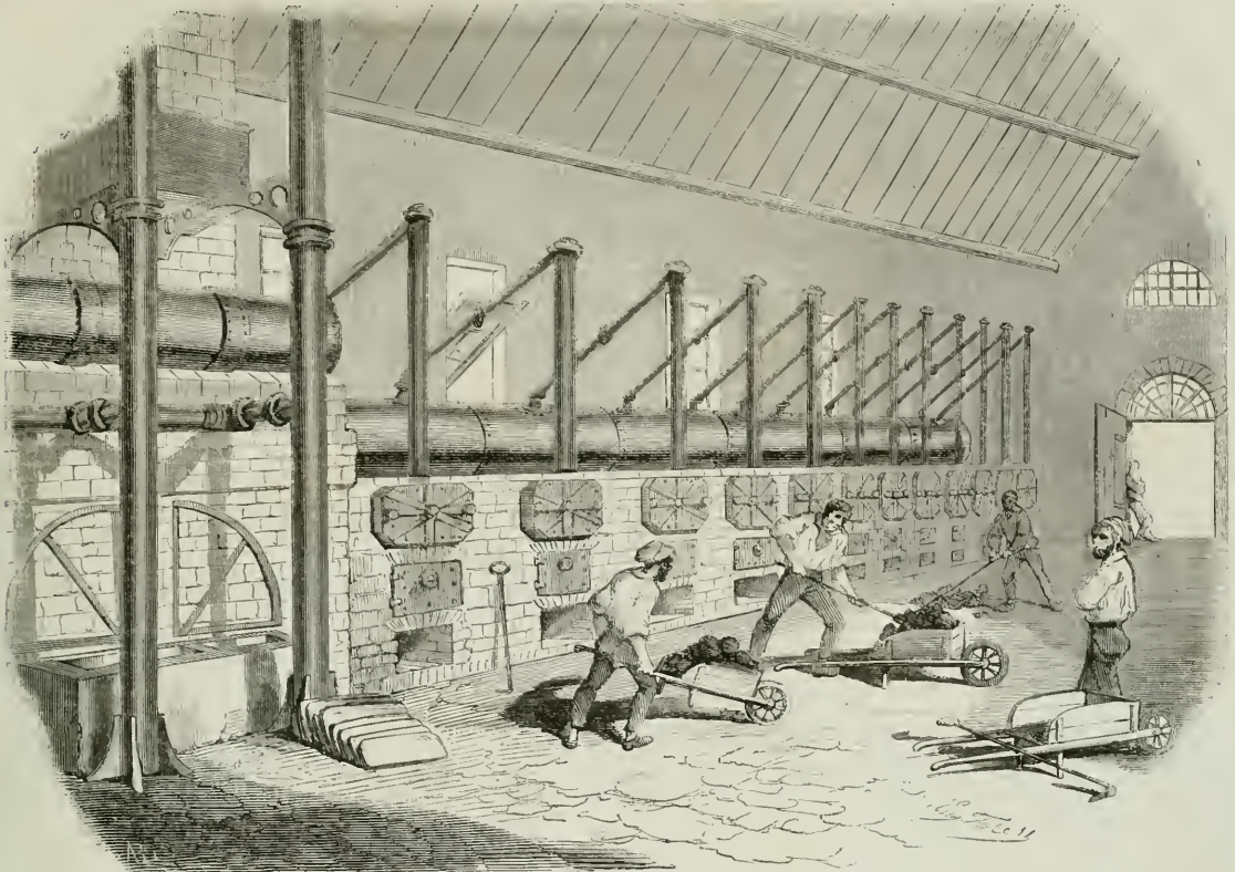
(Fabrication du Gaz. — Atelier de distillation.)
