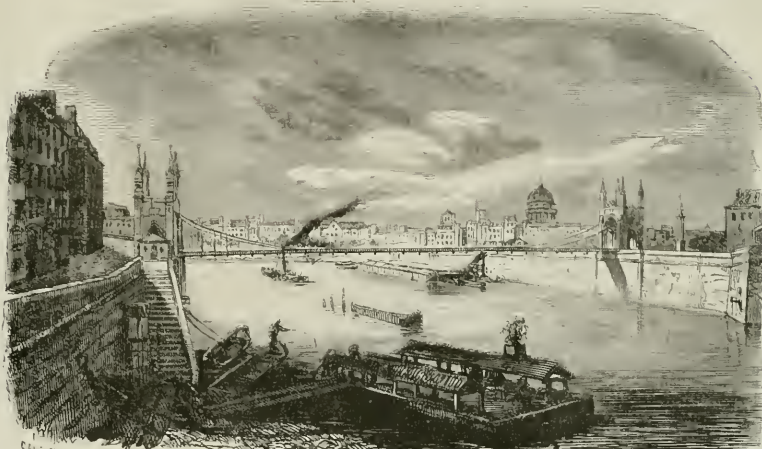
(Pont de la Cité, nouvellement construit entre la Cité et l'île Saint-Louis.)
