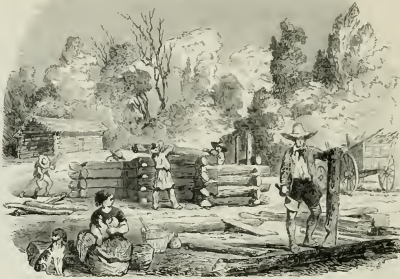
Souvenirs de Tennessee. — Construction d'un log-house.
