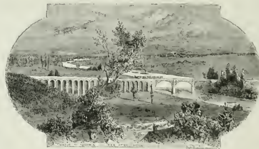
Viaduc du chemin de fer atmosphérique de Saint-Germain.
