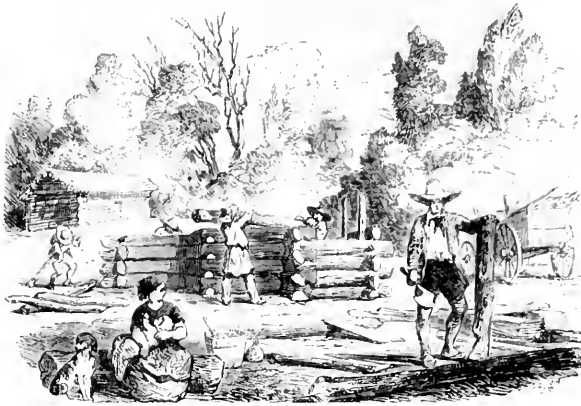
Souvenirs de Tennessee. — Construction d'un log-house
