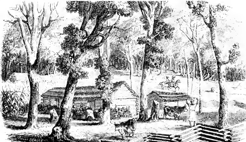
Log-house avec écurie et étable.
