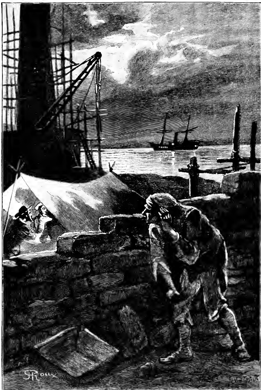
CARCANTE PUT SE RENDRE COMPTE DE L'ÉTAT DES TRAVAUX. (Page 50.)
