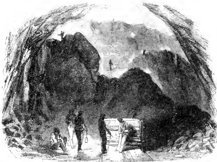
PRIMI LAVORI PER IL TRAFORO DEL FRÉJUS.
