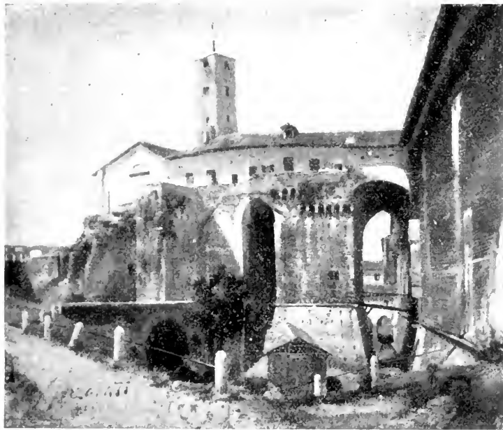
LA ROCCHETTA SFORZESCA CON LE SOPRA-COSTRUZIONI AUSTRIACHE NEL CASTELLO DI MILANO.
