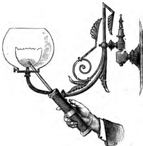
Fig. 68. — Mode d'emploi de l'allumoir à gaz à étincelle d'induction.
