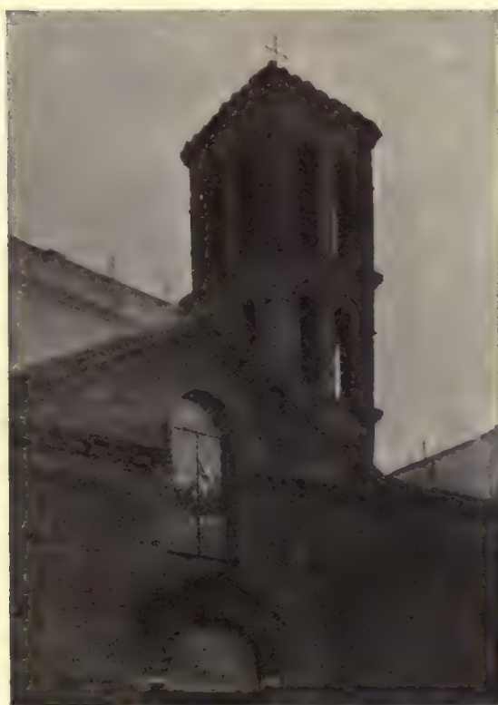
Fig. 601.—Rome. Santa Maria in Cappella. Campanile (1090).
