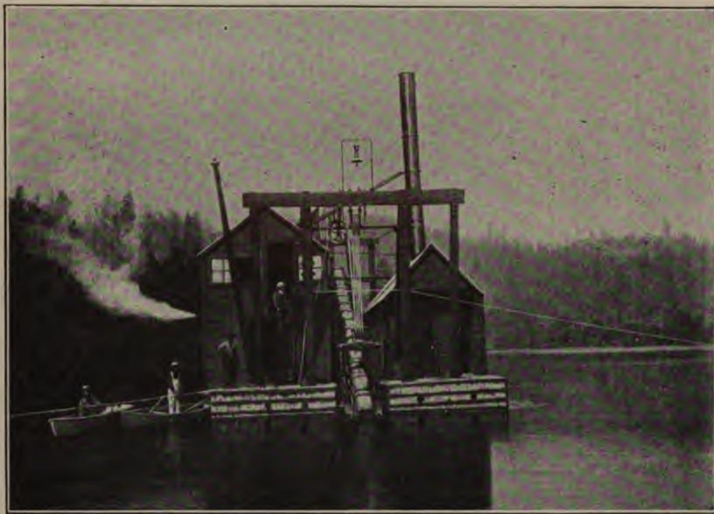
FIG. 44. — Drague à or au travail dans le lit d'une rivière.
