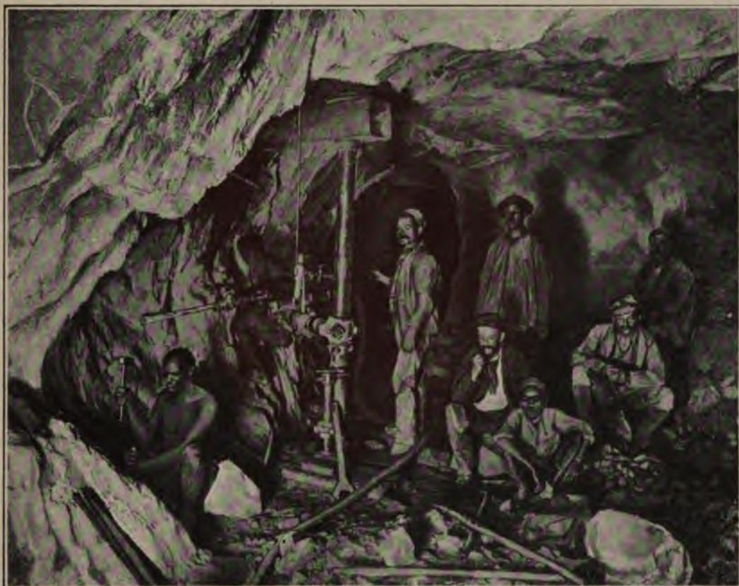
FIG. 55. — Une galerie de la mine New Primrose (Transvaal) avec la perforatrice en action. A 270 mètres sous terre.
