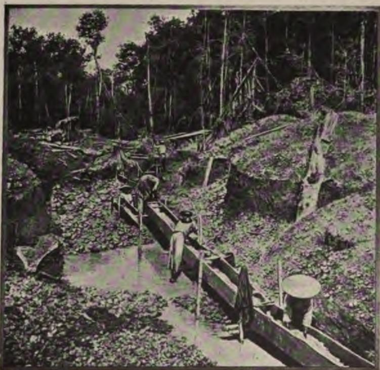
FIG. 177. — Débourage à la main dans les dalles. Travailleurs nègres et Annamites. (Cliché Gachet, obtenu par le vérascope Richard.)
