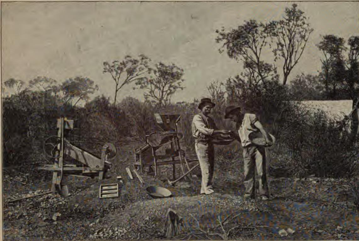
FIG. 21. — Vannage des sables à l'air, en Australie.
