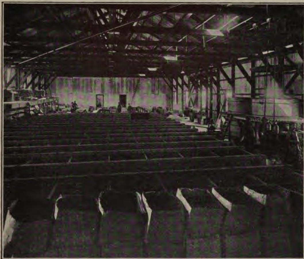
FIG. 84. — Salle des extracteurs. — Cuves à zinc pour l'extraction de l'or contenu dans le cyanure. (East Rand Proprietary Mine, à Driefontein, Transvaal.)
