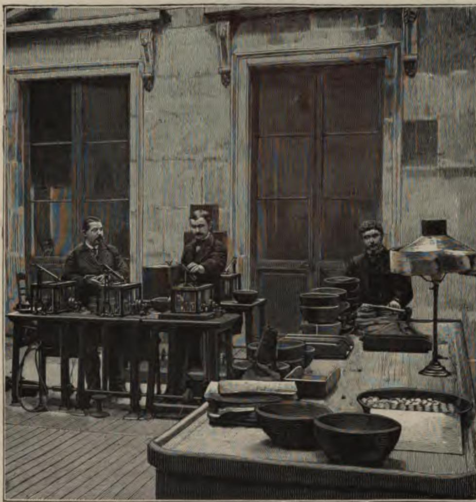
FIG. 268. — Trébuchets électriques de la Monnaie de Paris. — Le peseur verse les pièces dans la rigole située au-dessus de la cage vitrée. Dans les cages se voient les bobines des électro-aimants.
