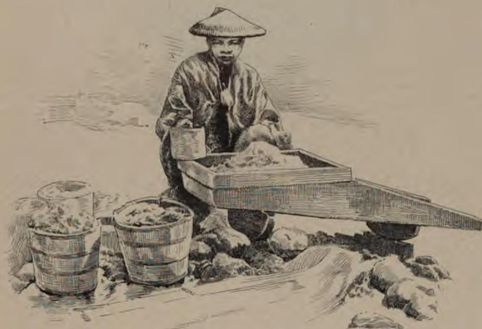
FIG. 27. — Chinois travaillant au berceau (D'après une photographie de M. Léval).
