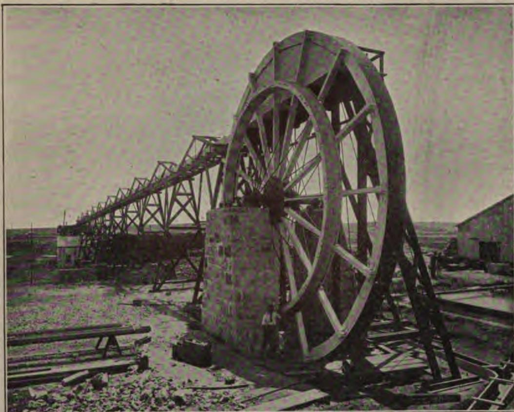
FIG. 86. — Roue élévatrice de la compagnie *The consolidated Goldfields of South Africa* (Johannesburg). Cette roue relève les tailings jusqu'à la hauteur de l'aqueduc, d'où ils se déversent dans les cuves, que l'on aperçoit à droite de la maison des ouvriers.
