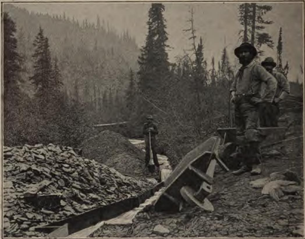
FIG. 34. — Sluice creusé à même la roche. — Bonanza creek (Yukon).
