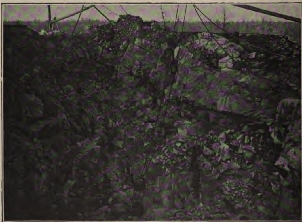
FIG. 141. — Mine du lac Saint-Georges (Colombie britannique). Le chantier d'abatage étant sur un flanc abrupt, le minéral est remonté au moyen de bennes et de poulies.
