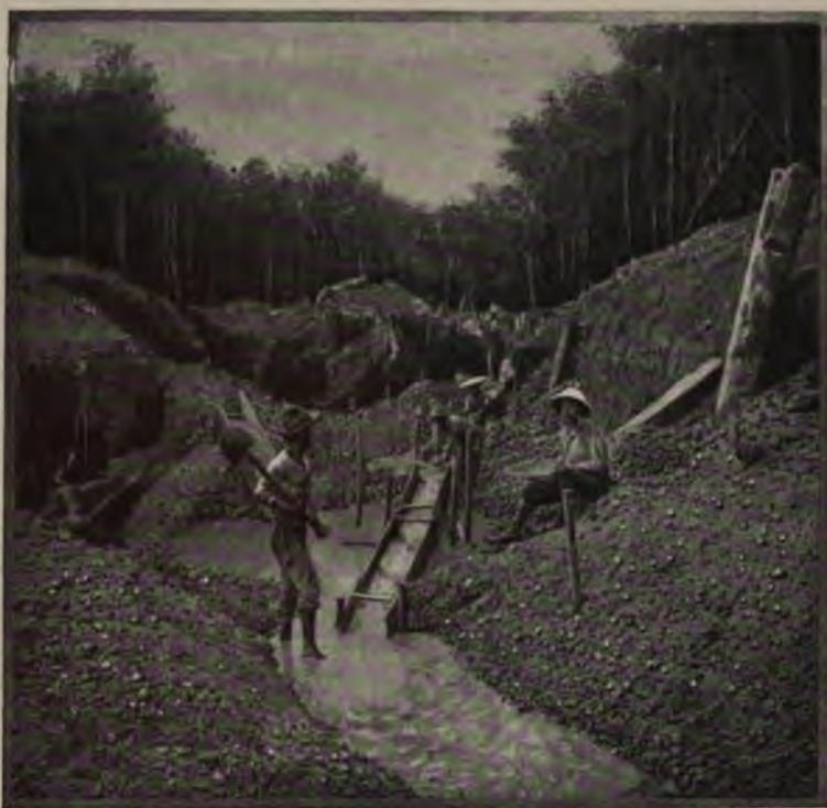
FIG. 176. — Chargement des dalles. A droite un prospecteur fait des essais à la batée. (Cliché Gachet, obtenu par le vérascope Richard.)
