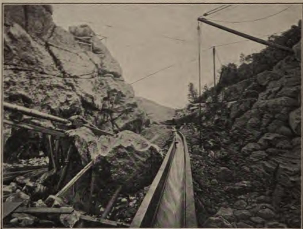
Fig. 98. — Long sluice dans le lit d'une rivière californienne (*Feather River*). — Les poulies servent à déplacer les gros blocs qui encombrant le sluice.
