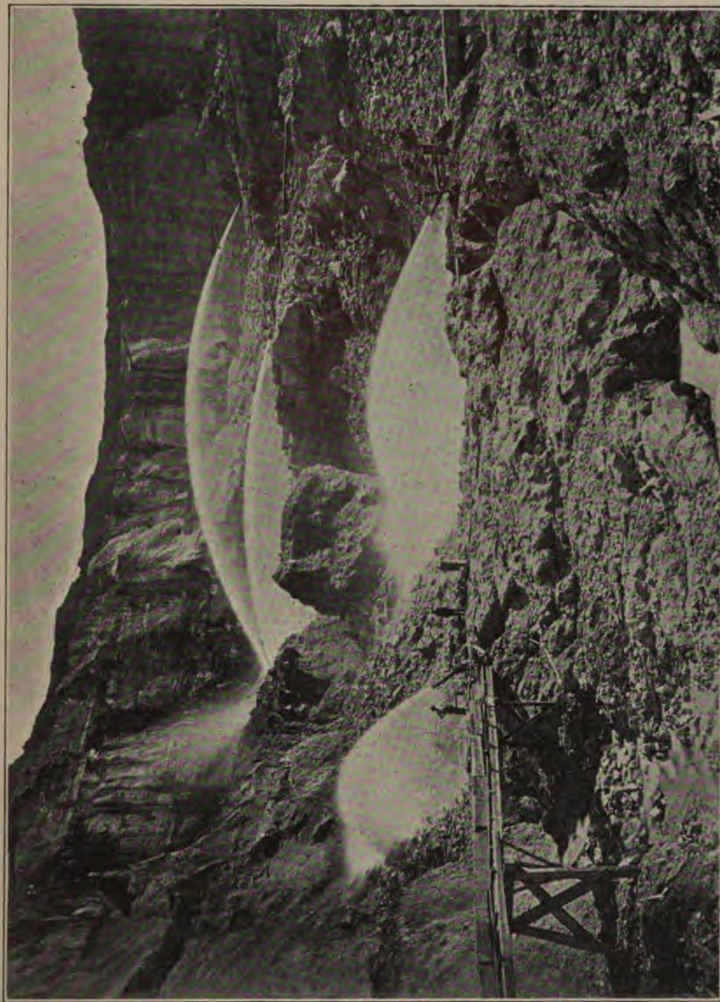
Fig. 37. — Désagrégation des roches par la méthode hydraulique: quatre *monitors* en action à la mine de North Bloomfield, Nevada Gr (Californie).
