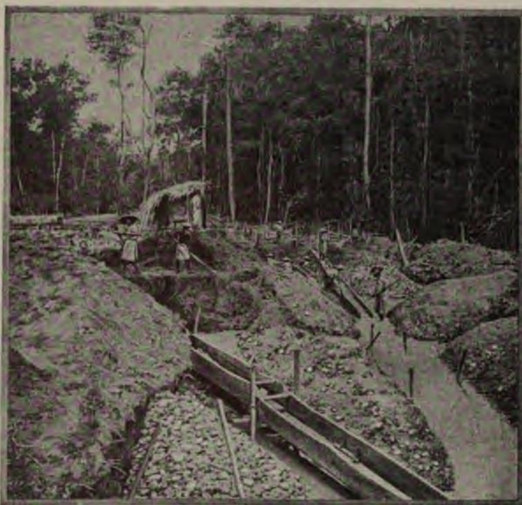
FIG. 174. — Vue d'un chantier d'abatage dans la forêt. Les dalles sont posées. (Cliché Gachet, obtenu par le vérascope Richard.)
