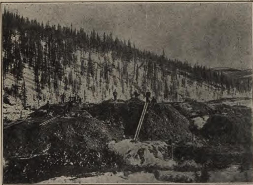
FIG. 163. — Chantier d'abatage d'un claim de vallée (Eldorado creek, Yukon). Le gravier est remonté au treuil.
