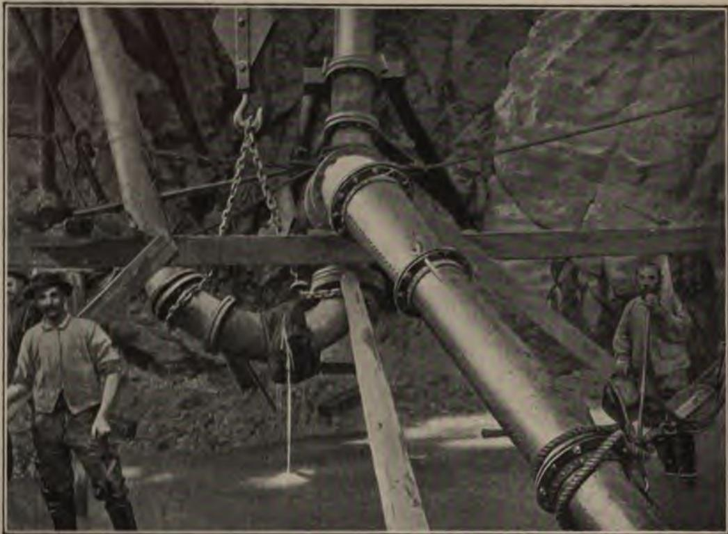
FIG. 41. — Tuyaux d'un élévateur dans une mine hydraulique californienne.
