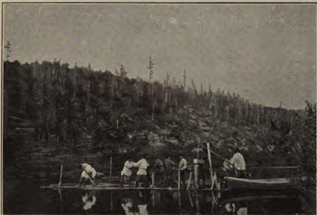
FIG. 193. — Orpailleurs clandestins manœuvrant une drague à bras. (Cliché de M. Levat.)
