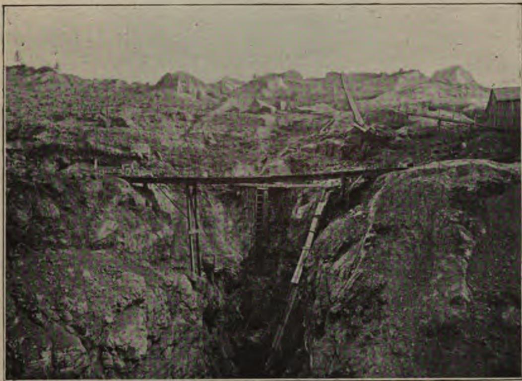
FIG. 33. — Un sluice californien. (Au-dessus de l'entrée du tunnel de la mine de North Bloomfield.)
