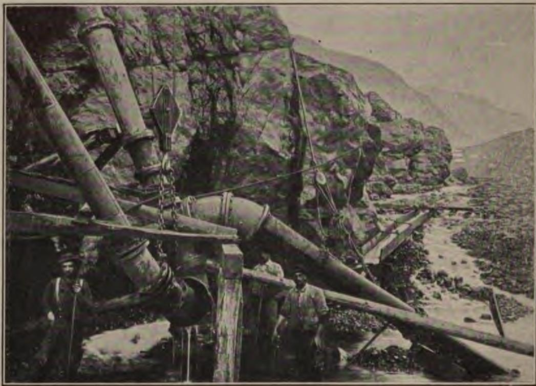
FIG. 100. — Détails d'un appareil de suction californien.
