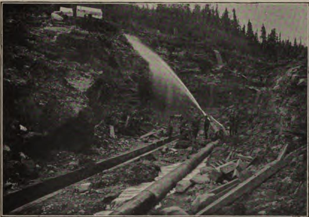
FIG. 143. — Mine hydraulique de Lamare (Atlin). A droite le tuyau d'amènée, à gauche le *sluice*.
