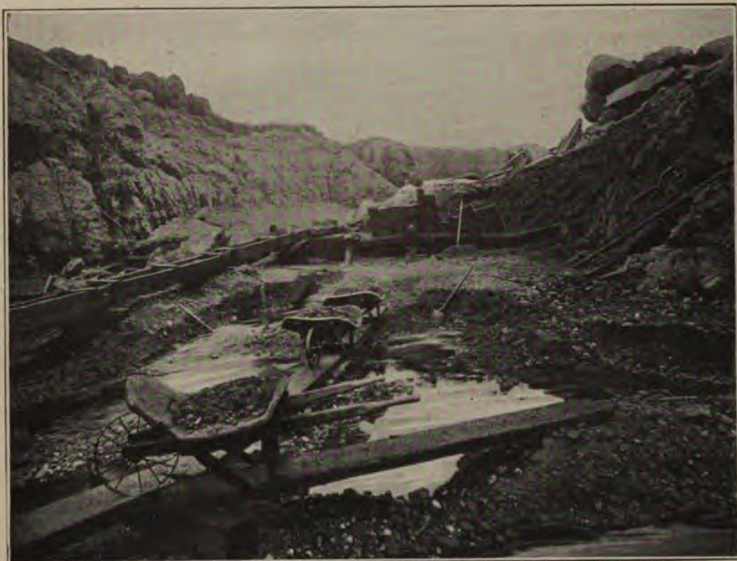
FIG. 31. — Un sluice californien. — Travaux dans le lit d'une rivière.
