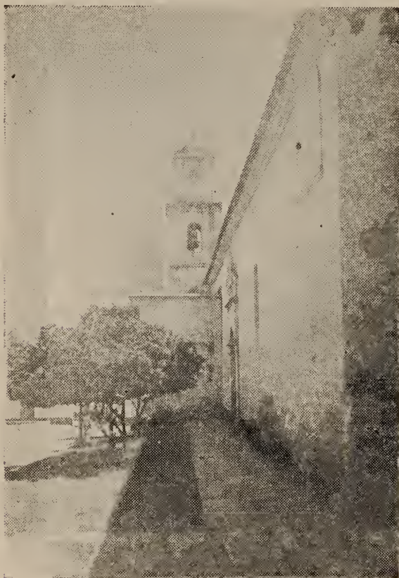
TORRE Y FACHADA LATERAL IZQUIERDA DEL TEMPLO MATRIZ
