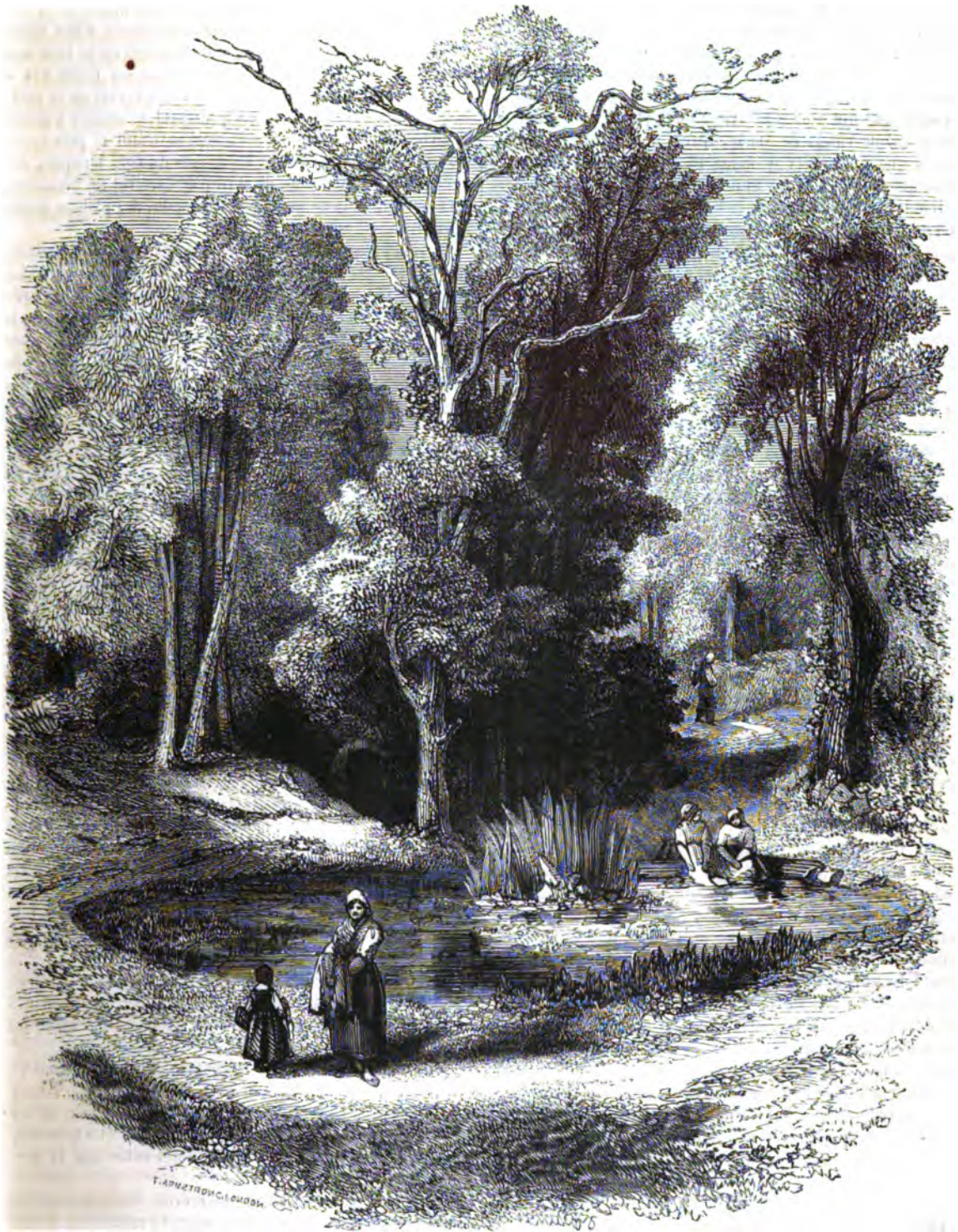
État actuel de l'un des bassins latéraux du second parterre de Marly.
