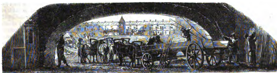
Vue de l'usine. — Chargement du fer en barres.
