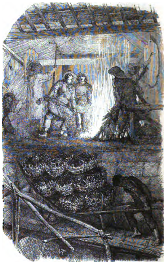
Chargement du minéral et du charbon au gueulard.
