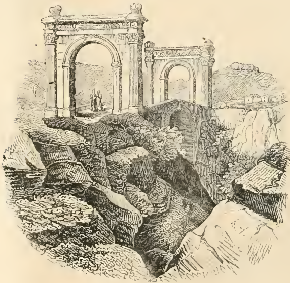
(Pont de Saint-Chamas.)
