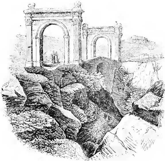
(Pont de Saint-Chamas.)
