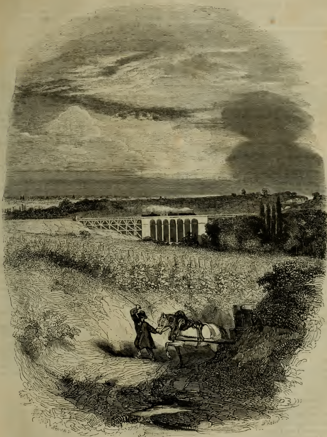
(Chemin de fer de Paris à Versailles rive gauche. — Viaduc du val Fleuri.)
