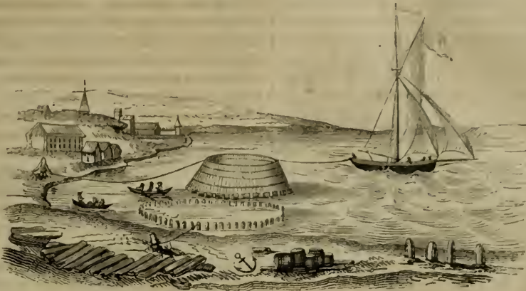
(Fig. 3. Remorque d'un cône du chantier de construction usqu'à la digue.)
