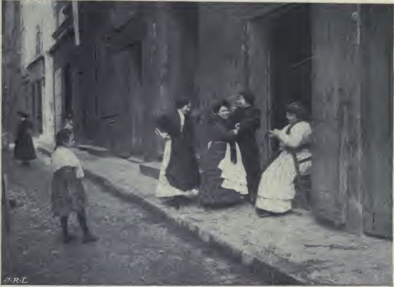
FIG. 7. — Une rue dans le quartier de la prostitution à Marseille.
