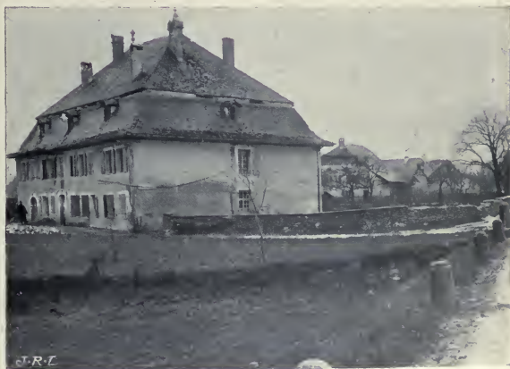
FIG. 64. — Photographie sur les lieux : les voies d'accès.
