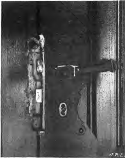
FIG. 23. — Le voleur a produit deux trous au vilebrequin, a entaillé avec le couteau le bois et a fait sauter ensuite le bois et la garniture de fer avec une pince.
