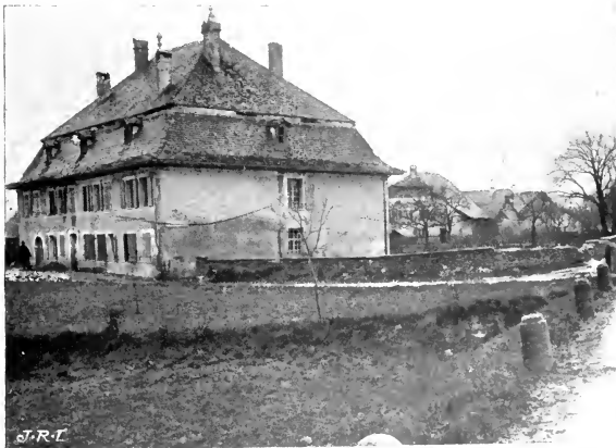
FIG. 64. — Photographie sur les lieux : les voies d'accès.
