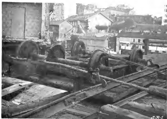
FIG. 66. — Photographie sur les lieux (accident) : chute d'une grue.
