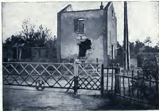
LEVEL- CROSSING NORMÉE
