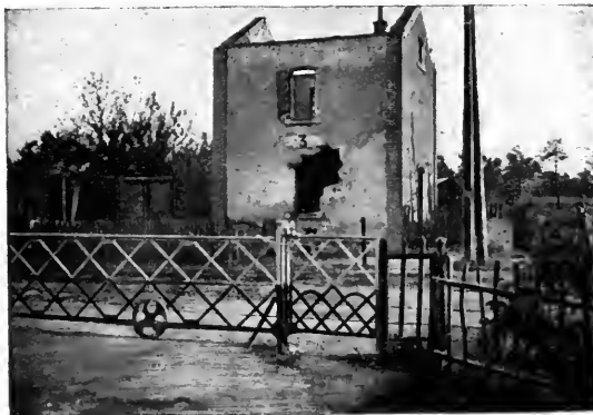
LEVEL- CROSSING NORMÉE
