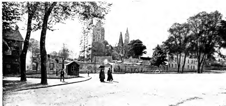
ENTRANCE TO THE RUE DE LA RÉPUBLIQUE AFTER THE FIRE
