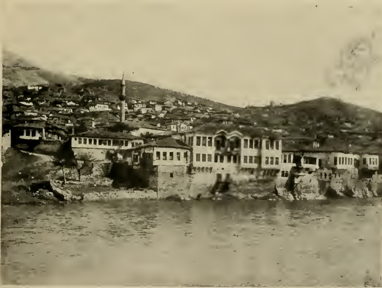
Abb. 64. Veles, Ostufer des Wardar mit Haremshäusern.
