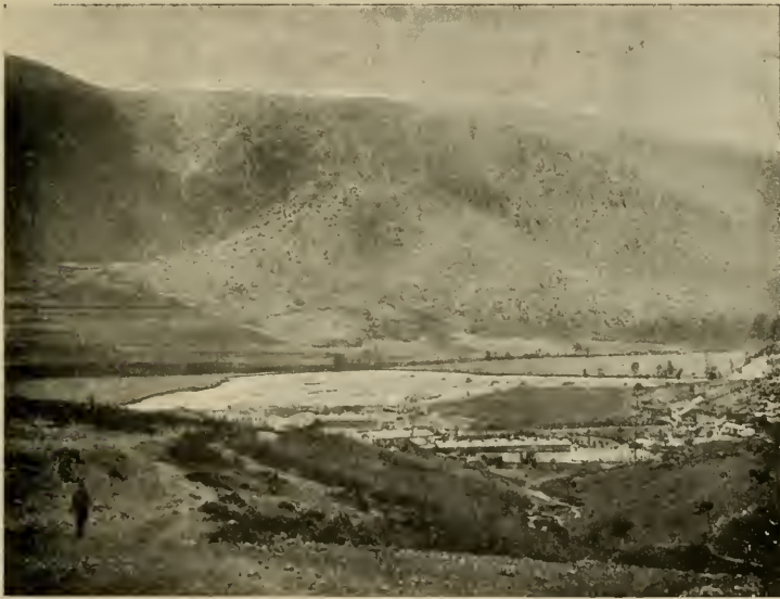
Abb. 163. Radsche. Lage am Fluß, Bahnstation und Häuser.
