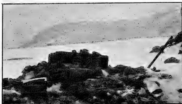
Fig. 10. Das Stationshaus in Pustervig im Mai nach Entfernung der Steinhülle.
