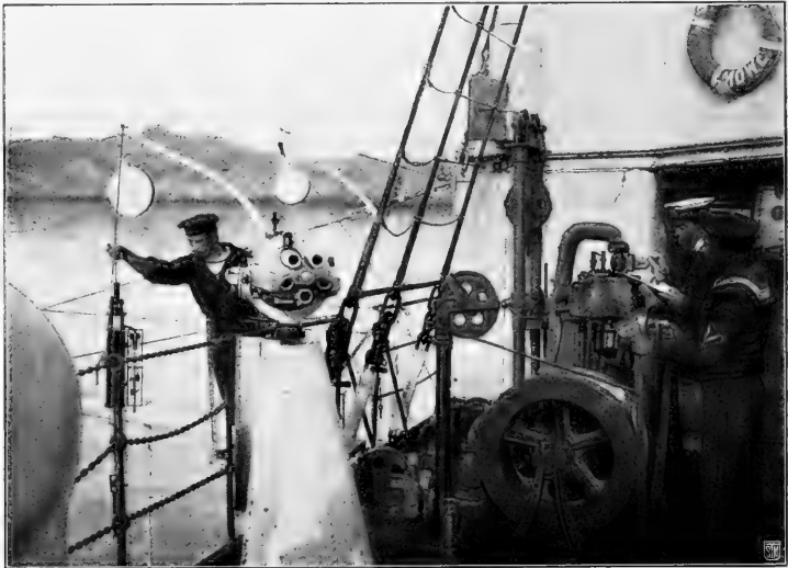
Abbild. 1. Die „Sigsbee-Lotmaschine“ und die „Ozeanographische Heißtrommel“.
