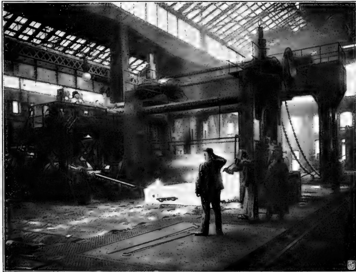
Abbild. 5. Walzen einer Panzerplatte.
