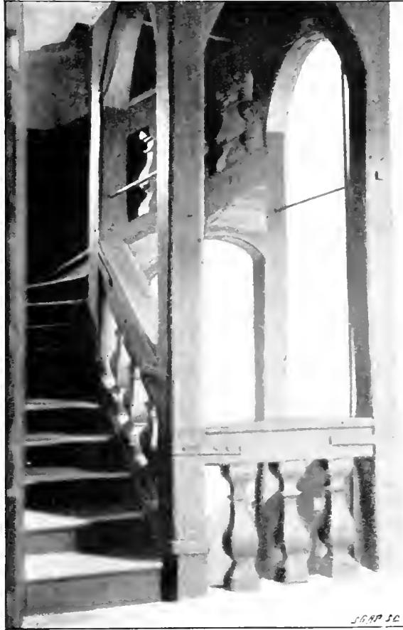
STAIRCASE OF THE HOUSE IN THE RUE DES BLANCS-MANTEAUX.
