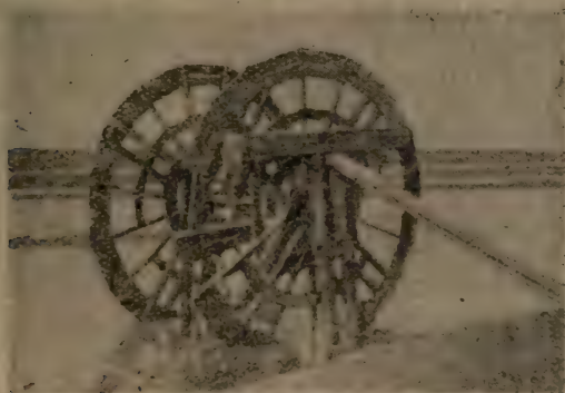
图72 在乔巴山城地区克魯倫河上的水車(汲水車)
