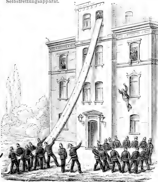
5. Rettungsschlauch und Sprungtuch.
