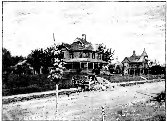
RESIDENCE OF A. V. B. CO., L. V. ST.
