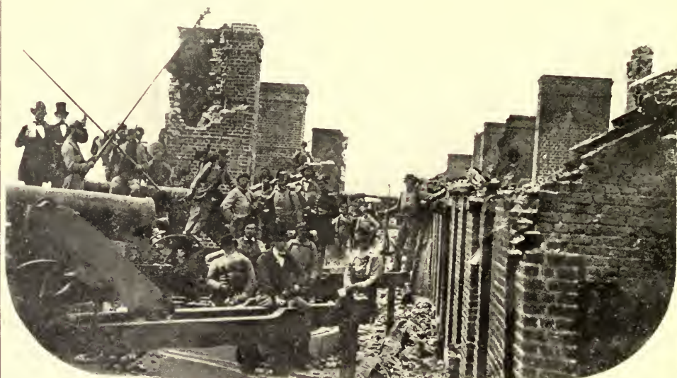
TERRE PLEIN OF THE GORGE.
