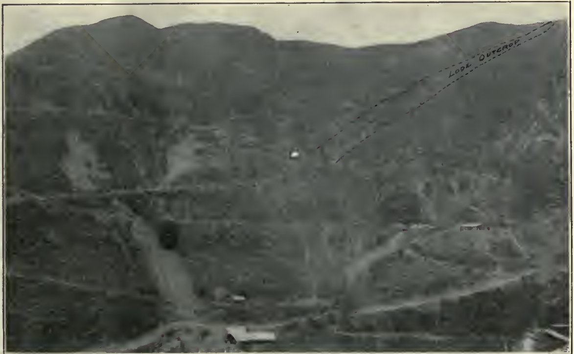
Reforma Mine, Campo Morado, Mexico.
