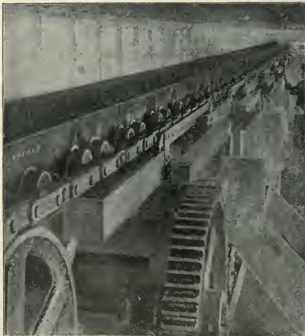
Fig. 2. Drop-Pan Conveyor.
