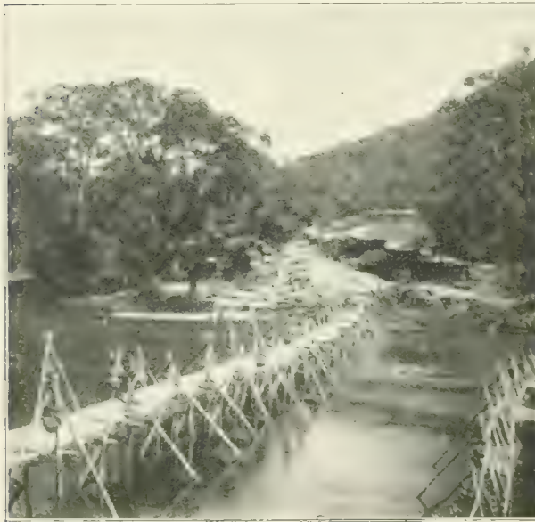
Fig. 89. — Pont thaï. — Muong Het.
