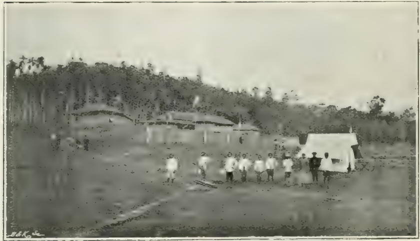
FIG. 18. — Maison construite pour M. Mac-Gaithy — son installation provisoire.
