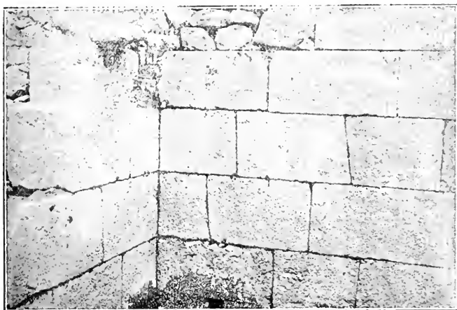
Fig. 3.— Nordwest-Ecke des Bassins.
