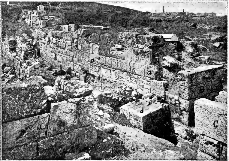
Abb. 3. Mauerstrecke A, Stadtseite.
