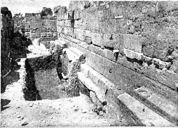
Abb. 11. Mauer DD_1 , Stadtseite, mit den Resten des römischen Kanals; im Hintergrunde Turm C.
