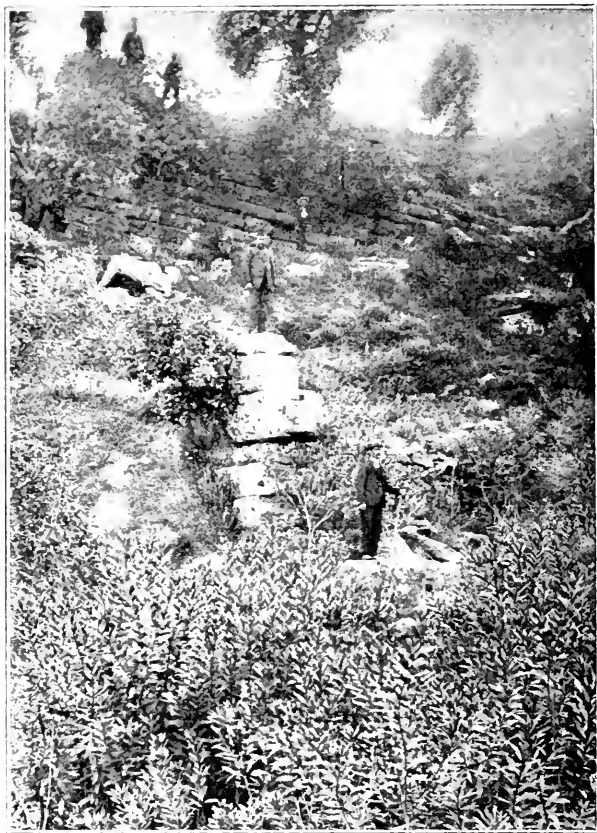
Abb. 5. Talsperre bei Ποξάδο.
