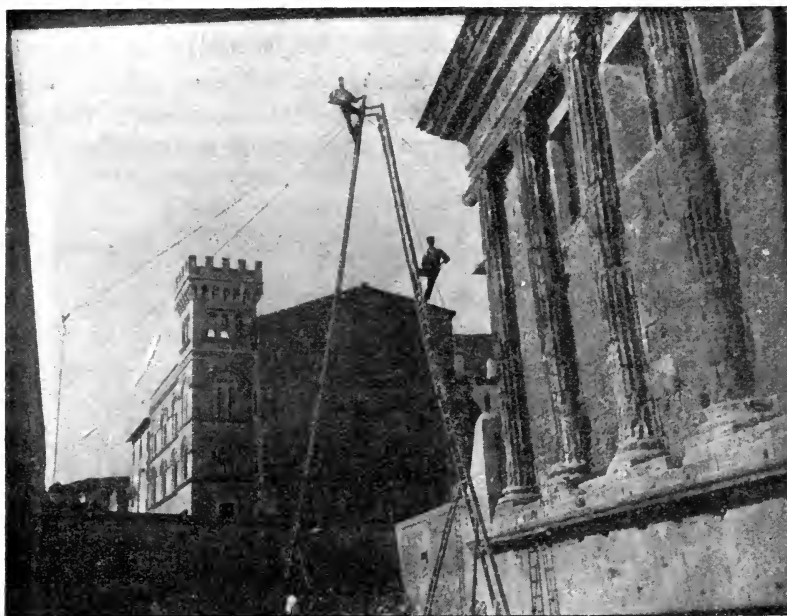
Fig. 2. Nördliche Hälfte der Westseite.
