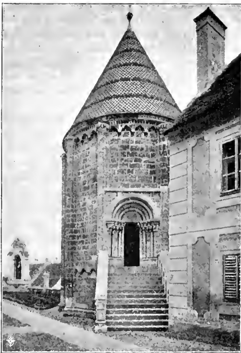
Fig. 8. (Außenansicht des Karners zu Hartberg von Westen.)
