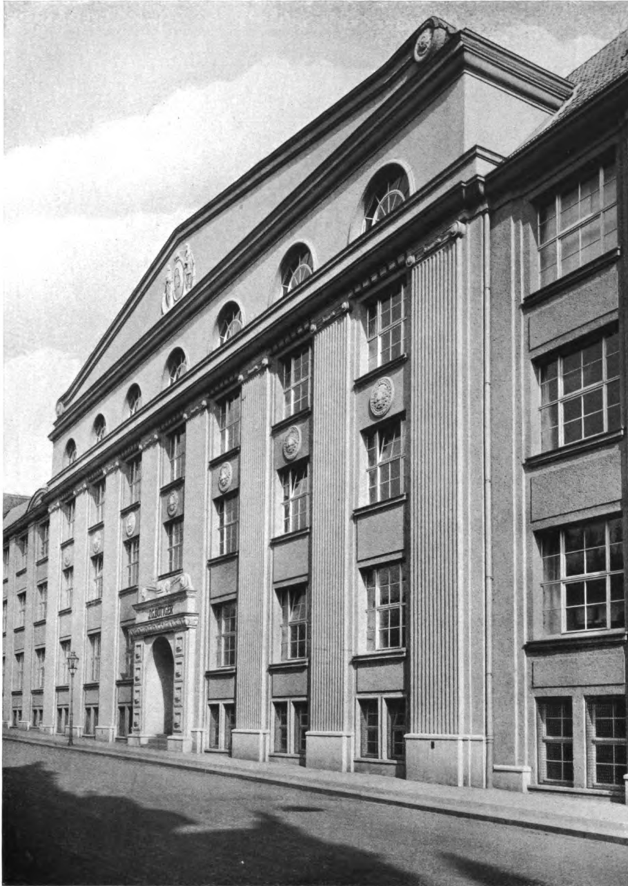
Zapp & Basarke, Chemnitz Das Geschäftshaus der Firma J. G. Böttger, Mechanische Weberei, in Hohenstein-Ernstthal
