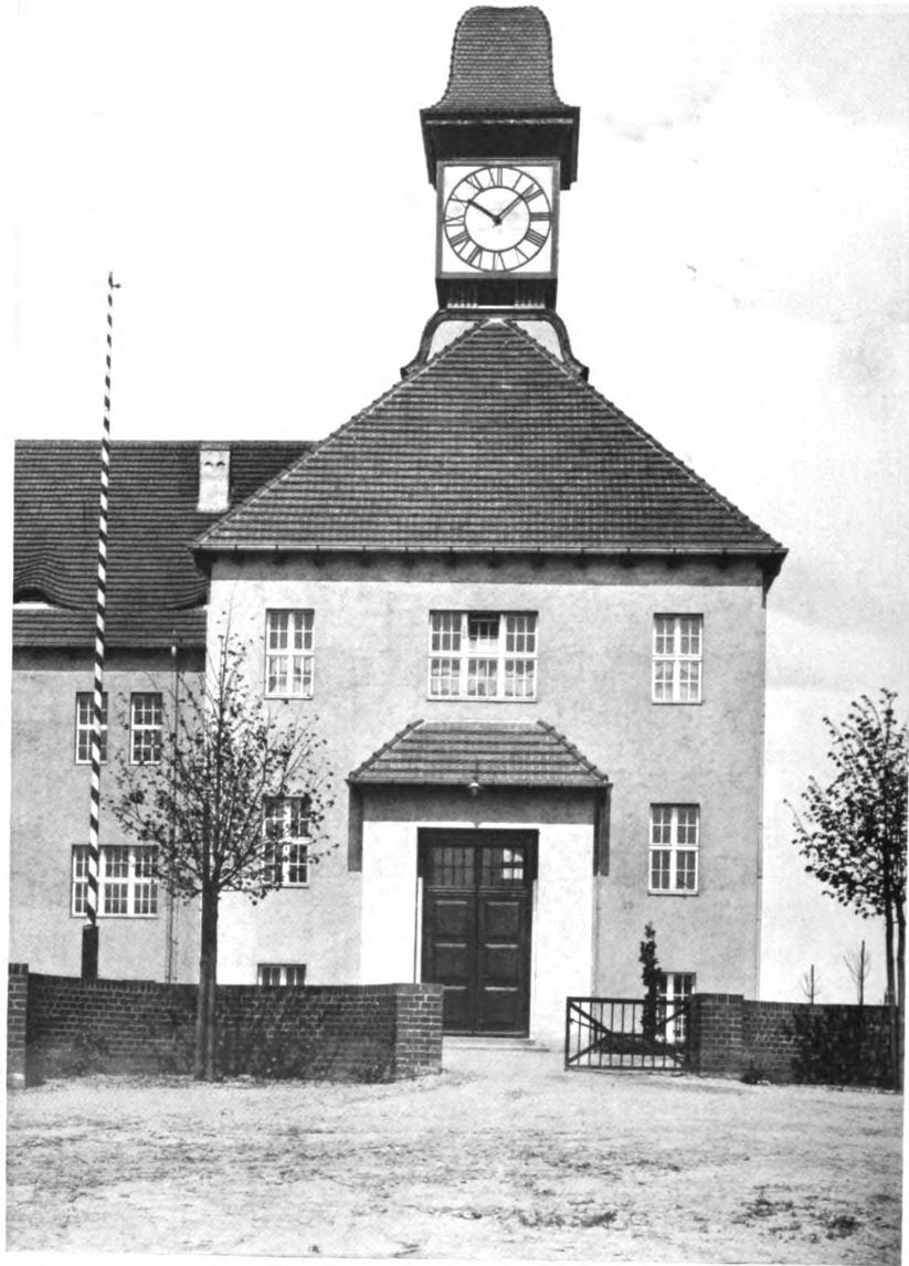
Albert Rieder, Berlin-Wilmersdorf Die Schule in Neuenhagen bei Berlin. — Der Eingangsvorbau mit dem Uhrtürmchen
