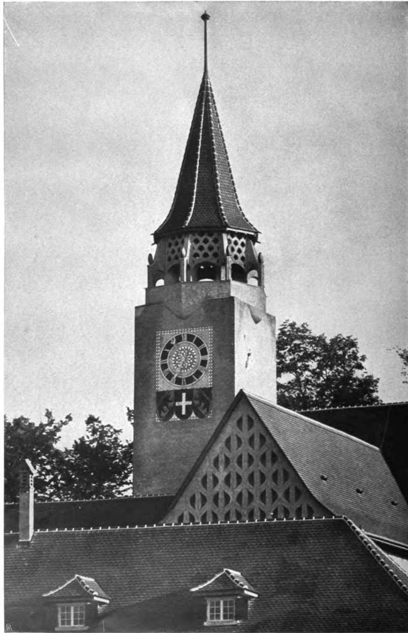
Karl InderMühle, Bern Blick auf den Kirchturm des „Dörfli“ der Schweizerischen Landesausstellung zu Bern Gewölbe der Glockenlaube in Rabitz und Stuck
