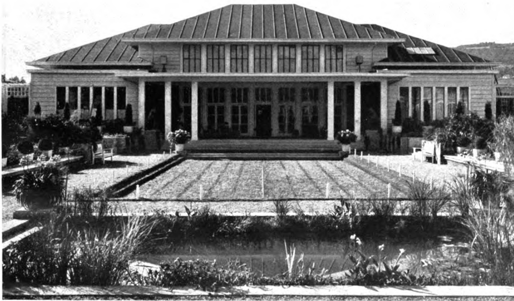
Professor Peter Behrens, Berlin-Neubabelsberg Das Ausstellungsgebäude des deutschen Werkbundes in Bern Oben: Blick von der Ausstellungshalle nach der Freilichtbühne. — Unten: Rückansicht der Ausstellungshalle
