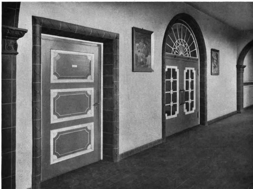
Pfeifer & Großmann, Karlsruhe i. B. und Mülheim a. d. R. Die Volksschule zu Kniclingen bei Karlsruhe i. B. Oben: Aus dem Treppenhaus. — Unten: Aus einem der Gänge
