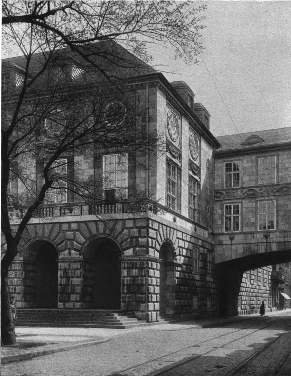
Pfeifer & Großmann, Karlsruhe i. B. und Mülheim a. d. R. Das Rathaus zu Mülheim a. d. Ruhr Eine Ecke der Marktfassade mit der Verbindungsbrücke
