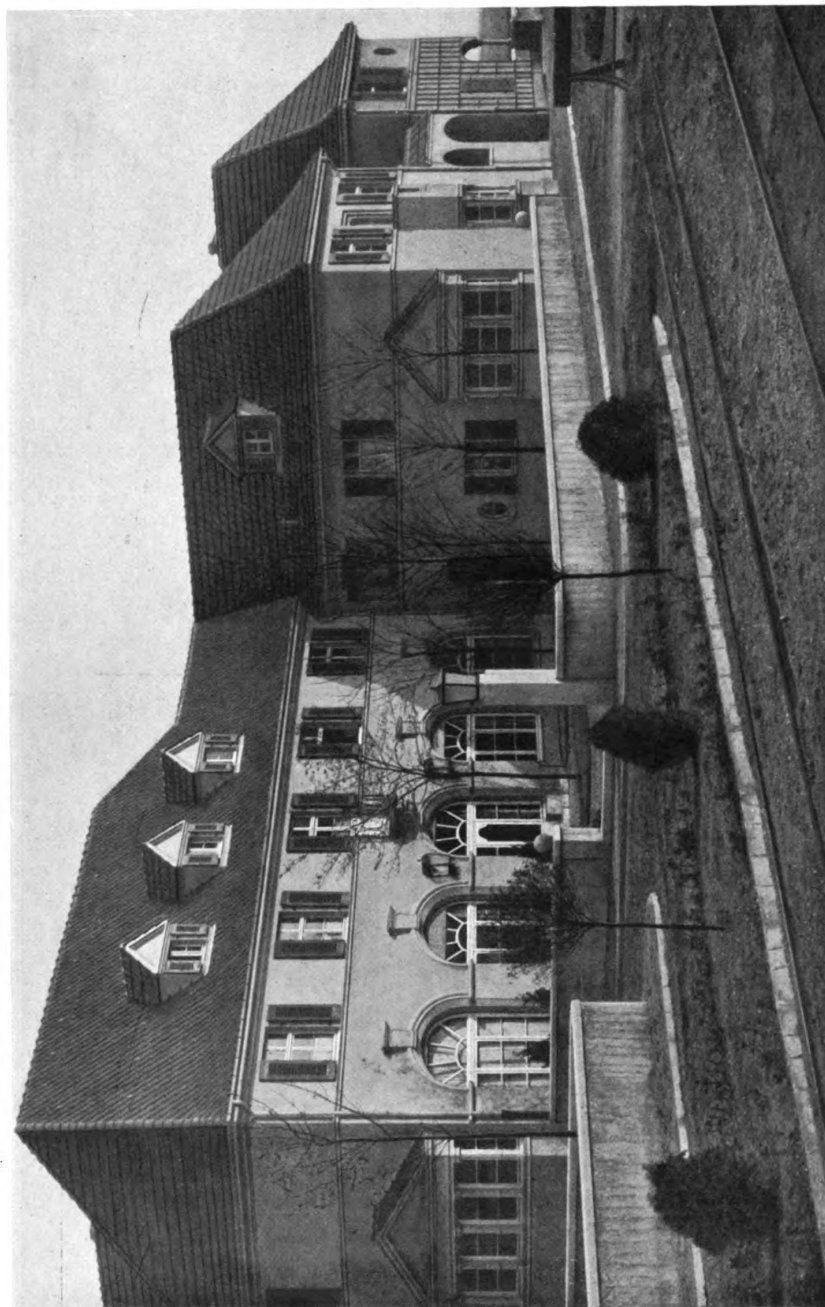
Walter Furthmann, B.D.A., Düsseldorf Die Siedlung des Wohnhaus-Vereins Monheim. — Das Kasino und Ledigenheim
