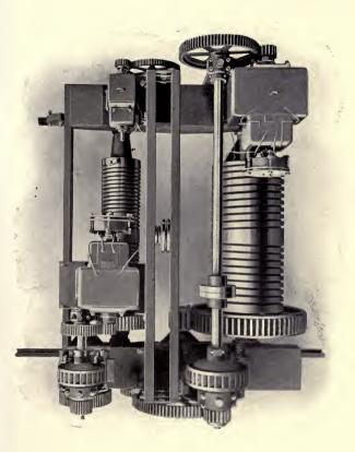
TROLLEY OF 15 TONS CAPACITY. The Case M'T' CO.
