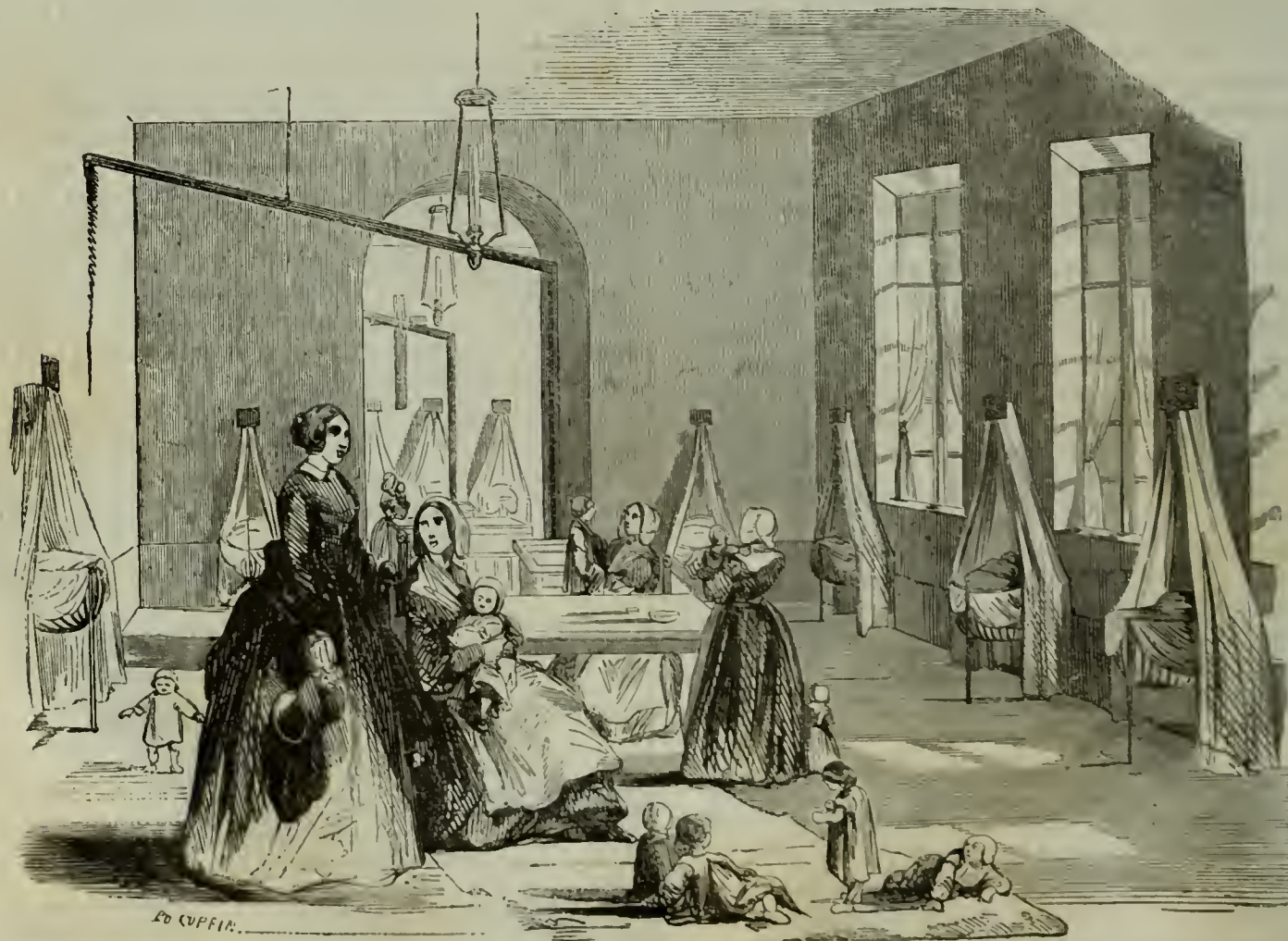
Vue de la crèche de la rue Saint-Lazare, n° 141.
