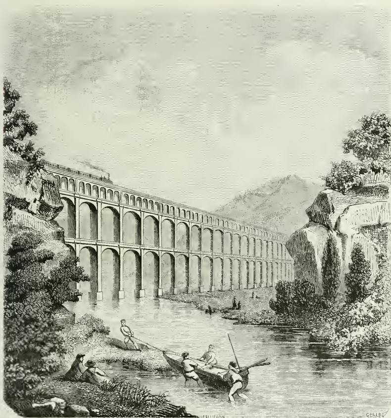
L'aqueduc de Roquefavour. Dessin de Fellmann
