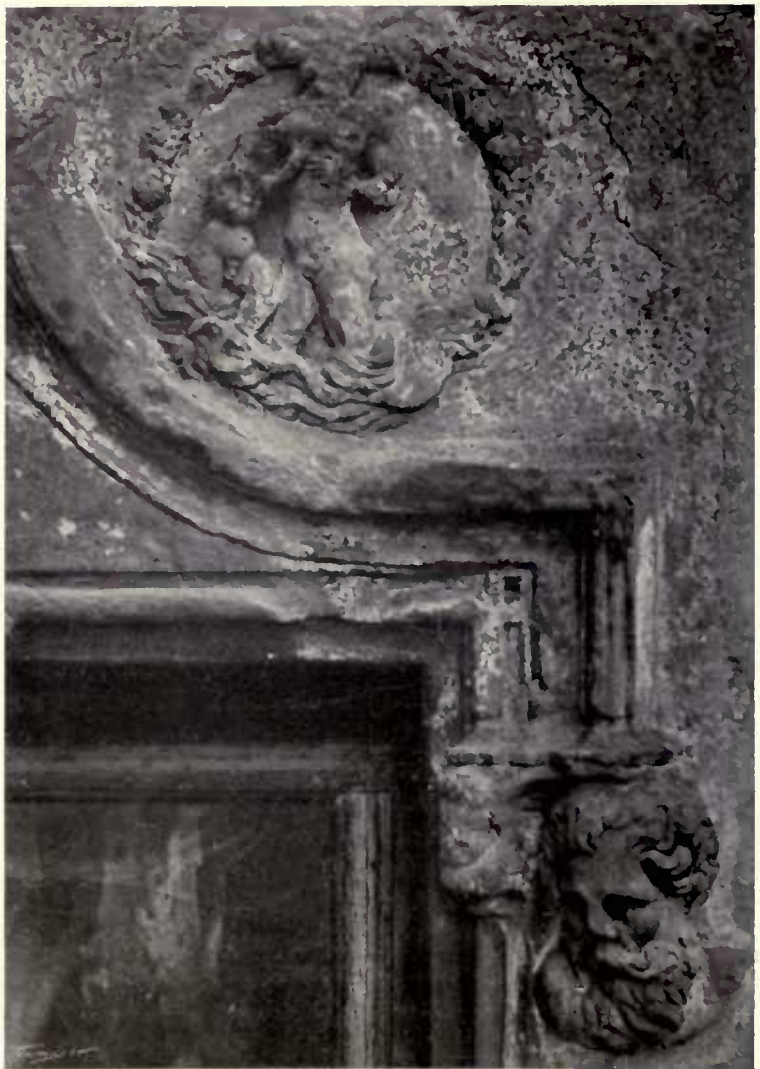
DETALLE DEL DINTEL DE LA CALLE DE FILATERAS (DERECHA)
