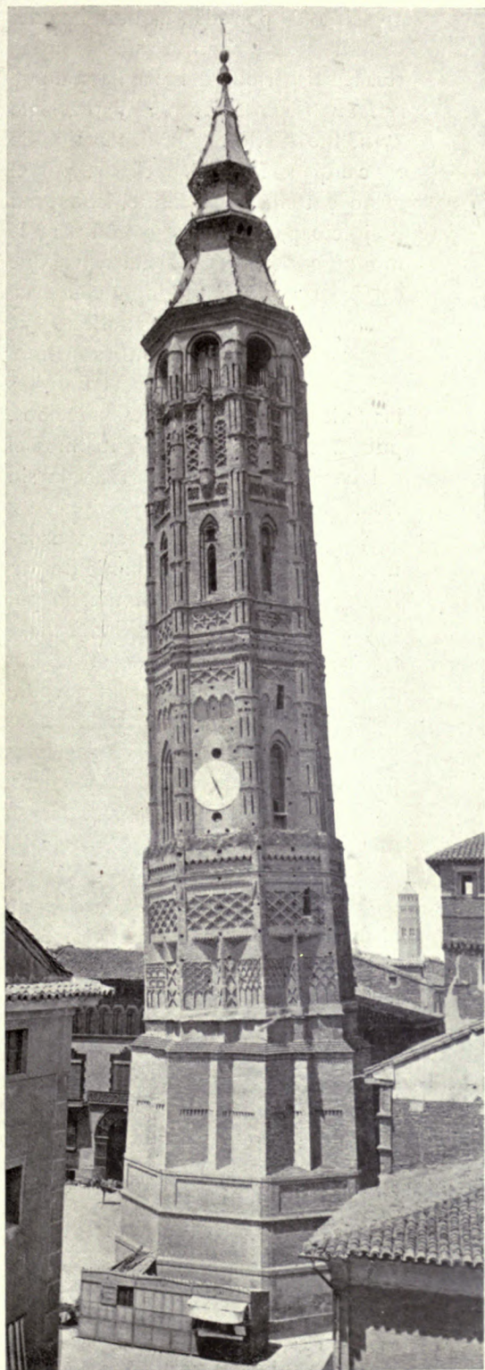
ZARAGOZA. TORRE NUEVA INCLINADA. (DERRUÍDA)
