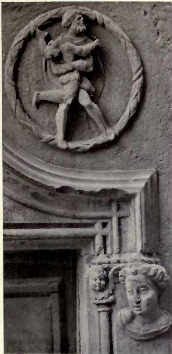
DETALLE DEL DINTEL. CALLE DE LA BORIA. (DERECHA)
