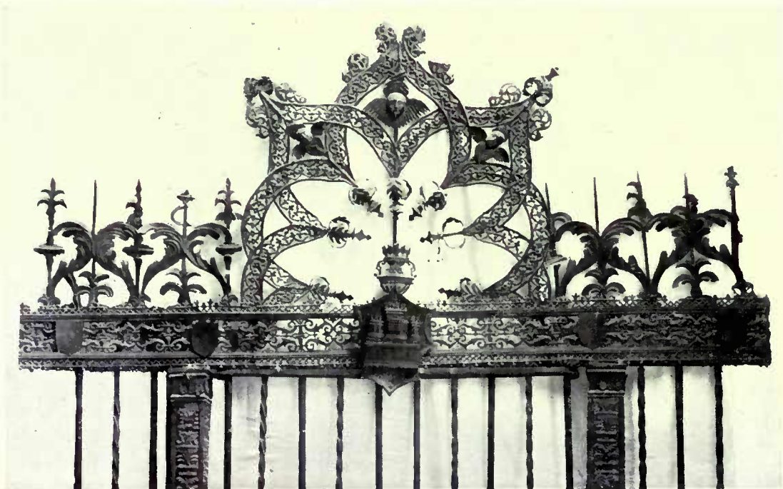
CORONAMIENTO DE LA REJA QUE CIERRA LA CAPILLA DE SANTA ANA
