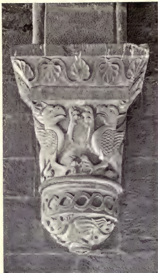
MÉNSULAS DEL GRAN DORMITORIO
