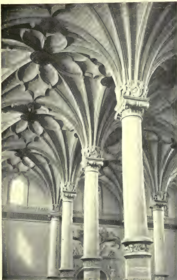
COLUMNAS Y BÓVEDA DE CRUCERÍA DEL SALÓN DE LA LONJA
