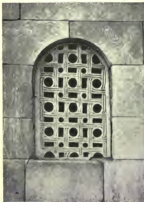
VALDEDIÓS. CELOSÍAS DE LAS VENTANAS DEL PÓRTICO
